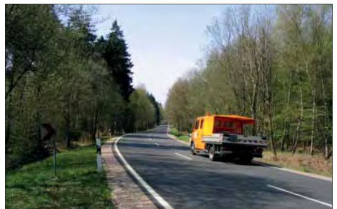
Abbildung 322: Die B 265 ist ein Beispiel für eine das Nationalparkgebiet durchtrennende, viel befahrene Straße (Foto: Andreas Pardey)
