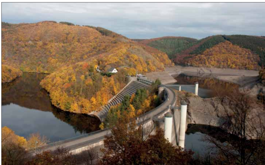
Abbildung 315: Die zwischen 1900 und 1905 errichtete Urfttalsperrenmauer trennt die Talsperre vom unterhalb liegenden Urftarm des Obersees (Foto: Andreas Pardey)
