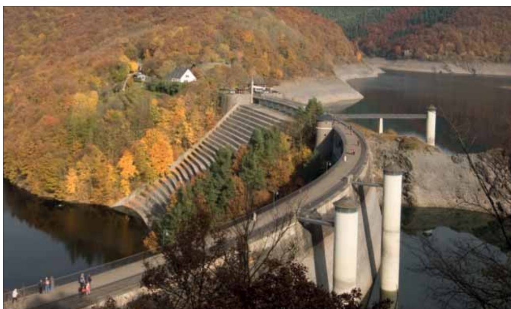
Abbildung 170: Die Urftstaumauer bildet eine für Fließgewässerorganismen unüberwindbare Barriere und unterbindet die Durchgängigkeit der Urft (Foto: Andreas Pardey)
