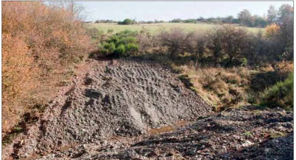
Abbildung 99: Beim Rückbau militärischer Überfahrten auf der Dreiborner Hochfläche wurde schadstoffbelastete Schlacken festgestellt (Foto: Andreas Pardey)
