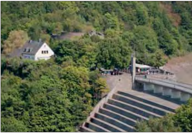
Abbildung 49: Der Kiosk an der Urftstaumauer ist im FNP als Sondergebiet „Gastronomie“ dargestellt (Foto: Andreas Pardey)
