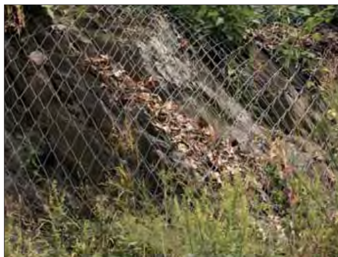
Abbildung 323: Am Urftseerandweg wurden Felsen mit Stahlnetzen verhängt (Foto: Andreas Pardey)
