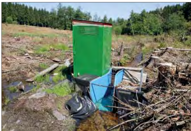
Abbildung 83: Venturi-Rinne der Abfluss-Messstation im TERENO-Projektgebiet am Wüstabach (Foto: Andreas Pardey)
