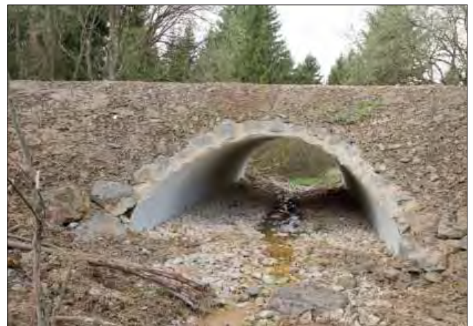
Abbildung 154: Im Rahmen des LIFE+-Projektes „Wald-Wasser-Wildnis“ wurde am Hollersief ein enges Rohr durch einen breiten Durchlass ersetzt (Foto: Andreas Pardey)
